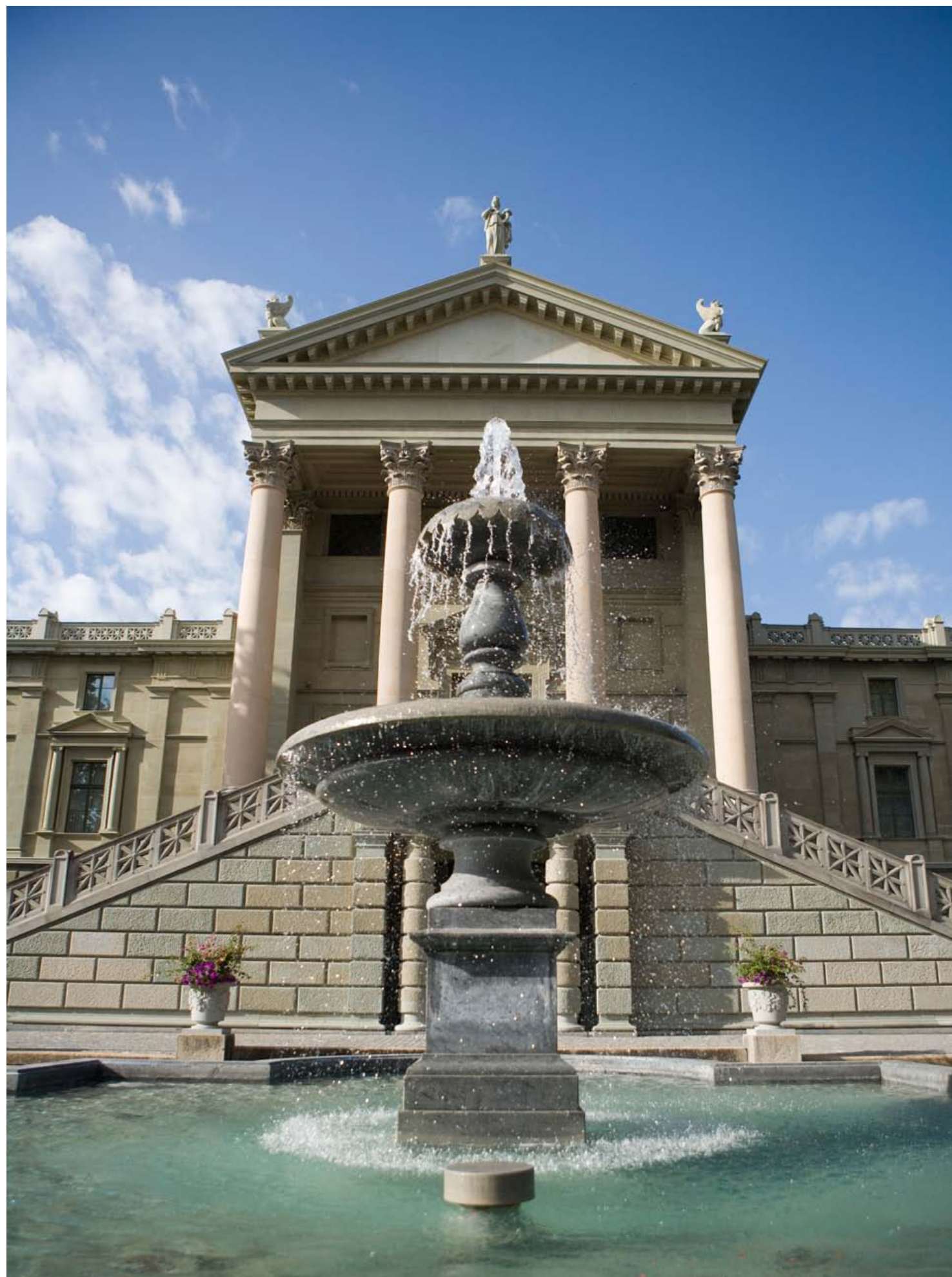
Das Stadthaus von Winterthur wurde zwischen 1865 und 1870 vom berühmten Architekten Gottfried Semper erbaut. Bis 1934 befand sich im Stadthaus der Gemeindesaal, heute finden hier Konzerte statt. In den Seitenflügeln des Hauses sind die Büros des Stadtrats untergebracht.
