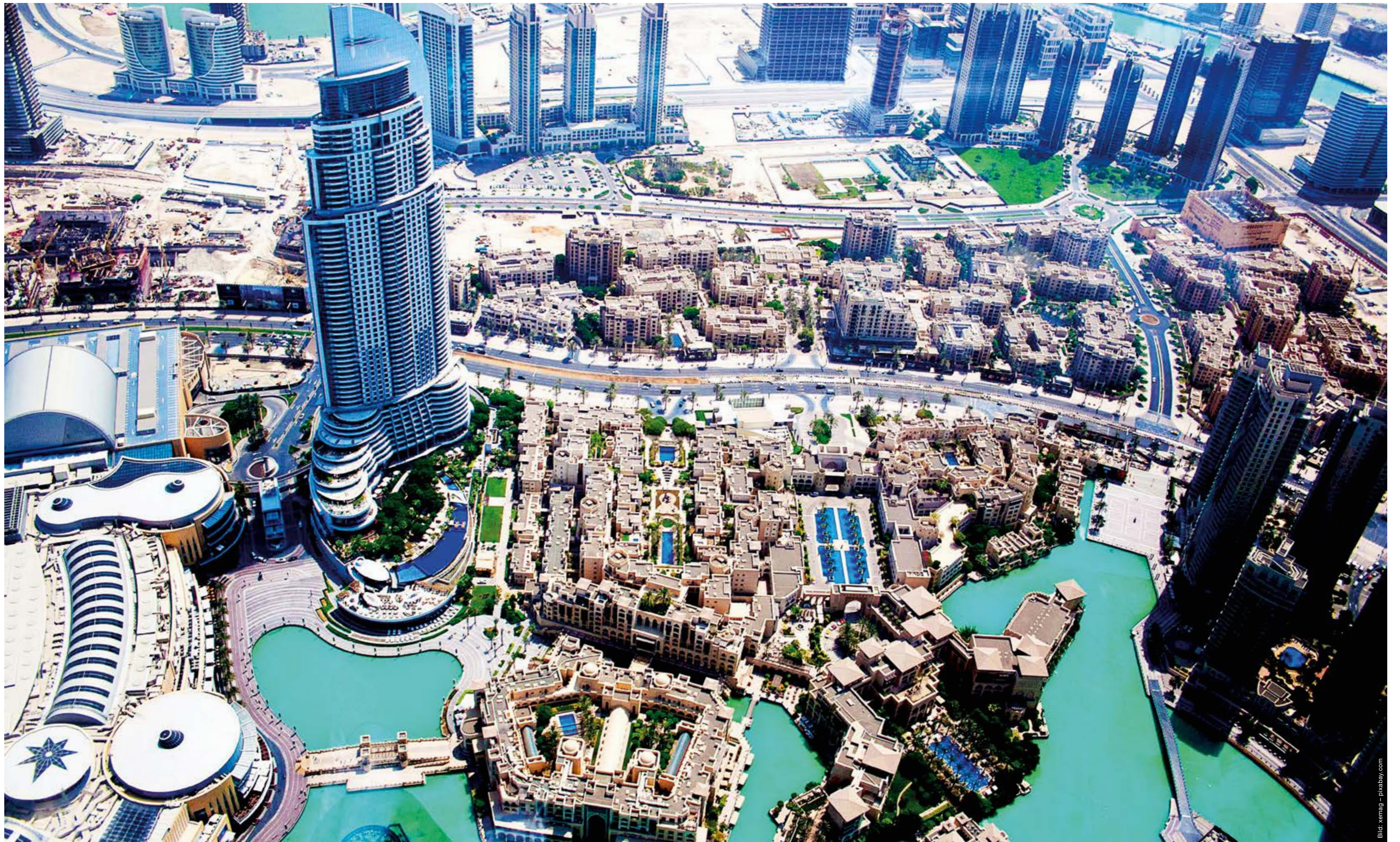
1966 wurde in Dubai Öl gefunden – ein Wendepunkt in der Geschichte des Emirats und der Beginn des modernen Dubai. Ein unvergleichlicher Bauboom begann. Heute prägen Wolkenkratzer und Mega-Projekte das Stadtbild.
